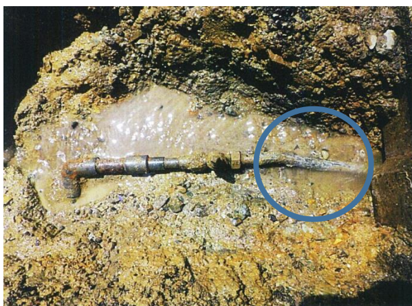
漏水修繕工事にあわせて鉛管撤去
