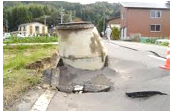
液状化によるマンホールの浮上(2004年 新潟県中越地震)
