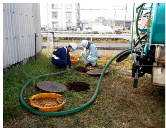
バキューム車による汚水移送作業
