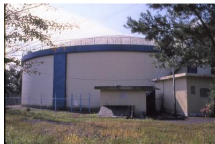
図：矢田配水池
