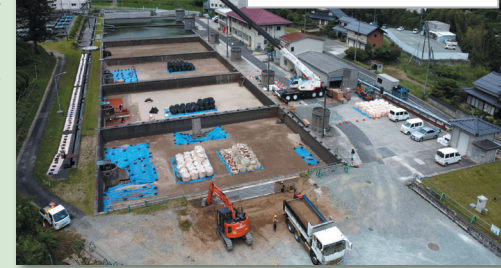
忌部浄水場耐震化工事
