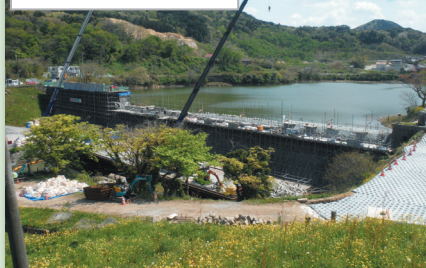
千本ダム耐震化工事
