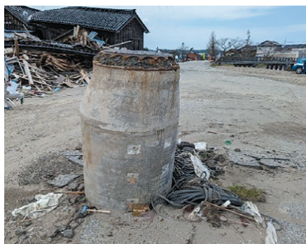
液状化によるマンホールの浮上 (2024年1月 能登半島地震)
