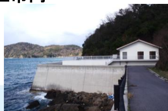
加賀浄化センター(漁業集落排水)
