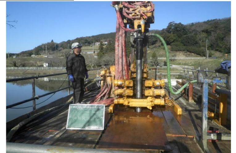
予備試験アンカー施工（アンカー孔削孔）の様子
