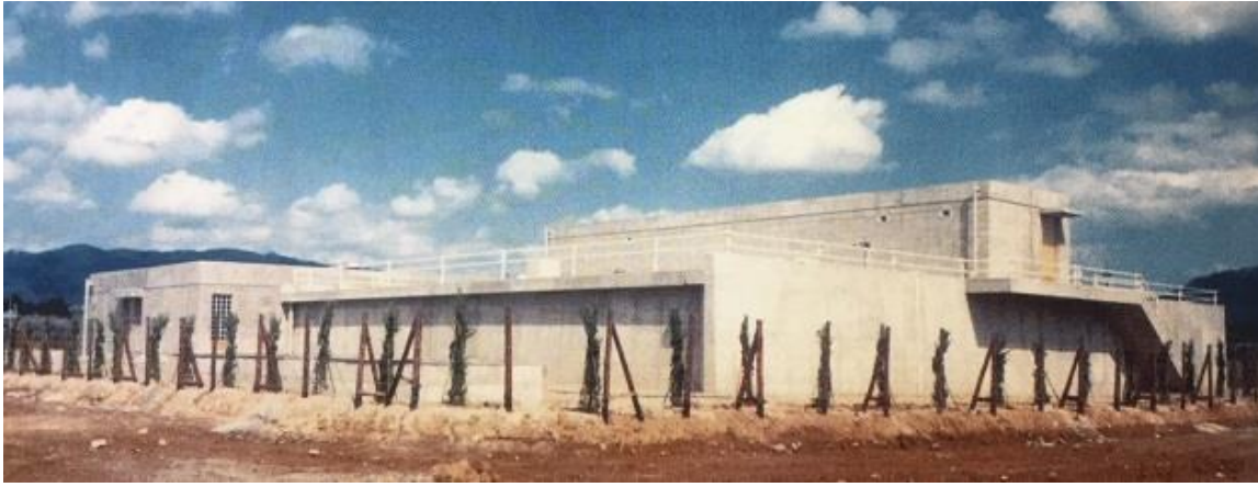
菅田ポンプ場
