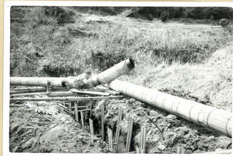
4月18日 パイプ曲管地上溶接 (水道作業道路)
