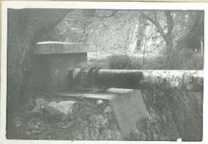
5月31日 千本堰堤下水管橋の1.7メートル口径伸縮管
