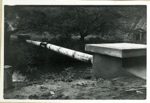
5月31日 千本堰堤下水管橋の全橋台竣工状況
