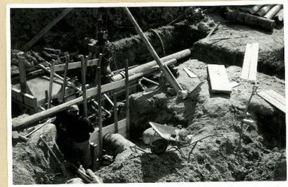
4月18日 400口径電動弁 (浄水場内) 布設
