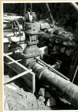
4月18日 400口径電動弁布設 (浄水場内)
