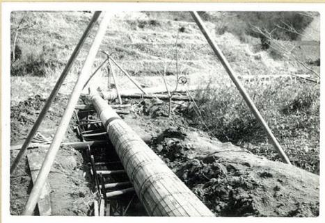
3月29日 パイプ地上溶接管配列 (水道作業道路)
