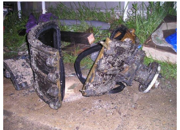
撤去した不断水分岐管
