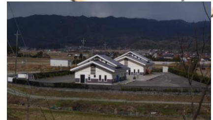
本庄浄化センター(農業集落排水)
