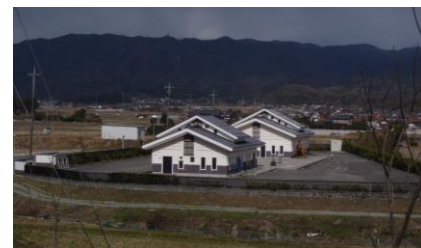
本庄浄化センター(農業集落排水)
