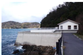
加賀浄化センター(漁業集落排水)
