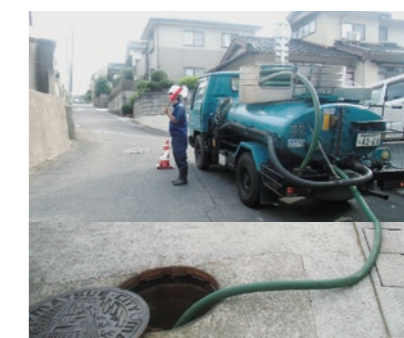
図2. バキューム車で汲み取り
