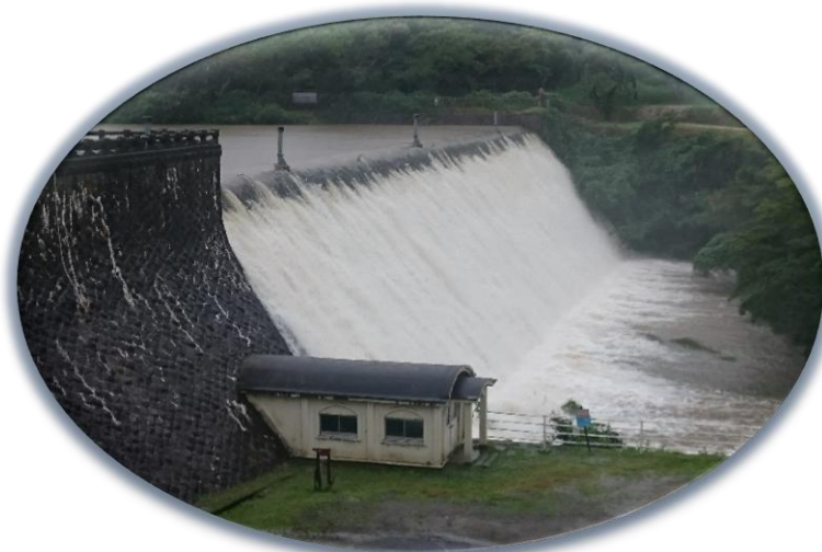
豪雨時、増水している千本ダム
