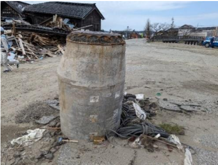
図：液状化によるマンホールの浮上 （2024 年 1 月 能登半島地震）
