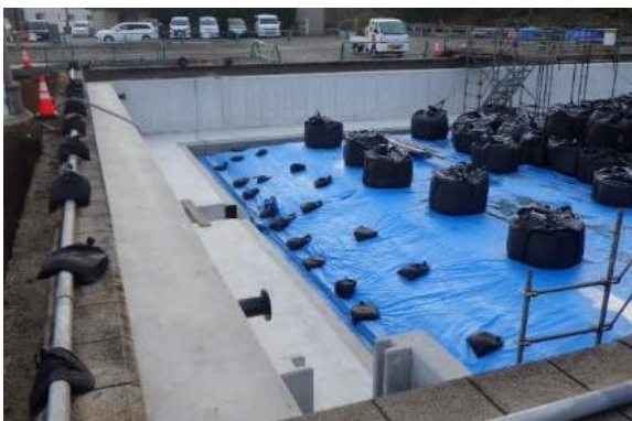
図：忌部浄水場ろ過池L型擁壁工法の施工状況
