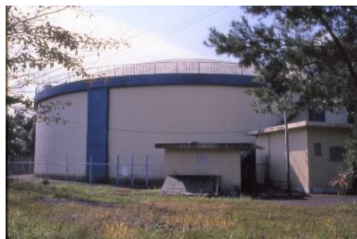
図：矢田配水池
