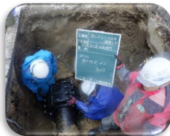
水道管漏水修繕の様子
