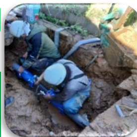
水道管漏水修繕の様子
