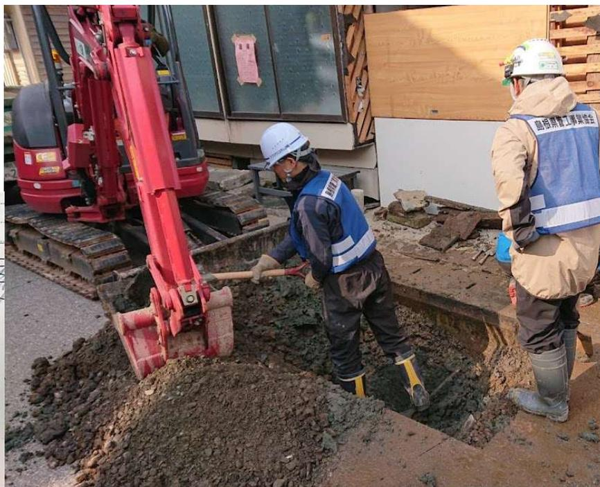
バックホーで漏水している水道管を掘り起こす作業。
