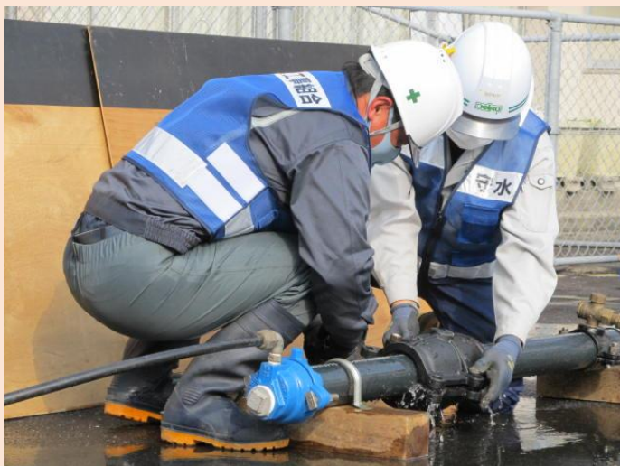
漏水修繕実演（松江管工事事業協同組合）
