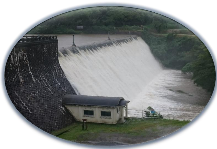
豪雨時、増水している千本ダム
