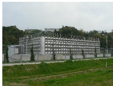
新乃白ポンプ場
