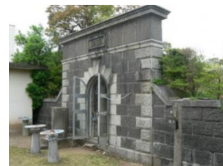
旧床几山配水池
