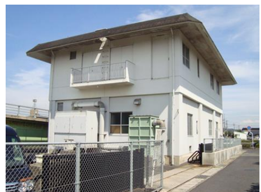
向島ポンプ場
