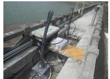
千本ダム 試験アンカー
