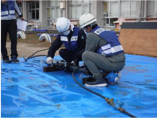
図：漏水修繕の実演の様子
