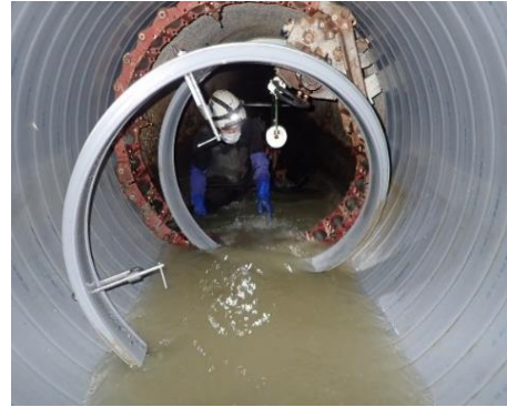
図:管路更生工事の様子
