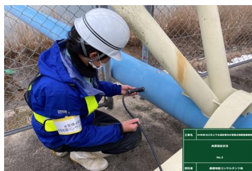
図：水管橋の点検(肉厚測定)の様子
