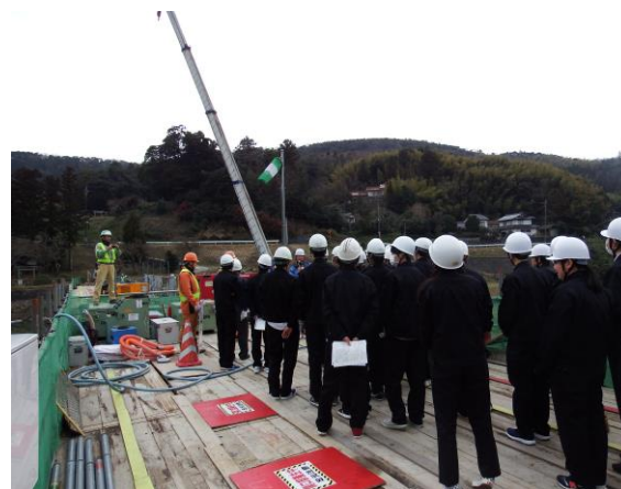
図：千本ダム工事現場の見学
