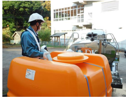
図：1 m 3 のポリタンクへの給水作業
