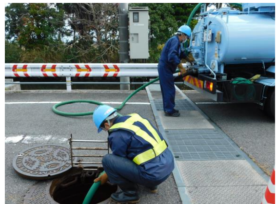
図：バキューム車による汚水移送作業
