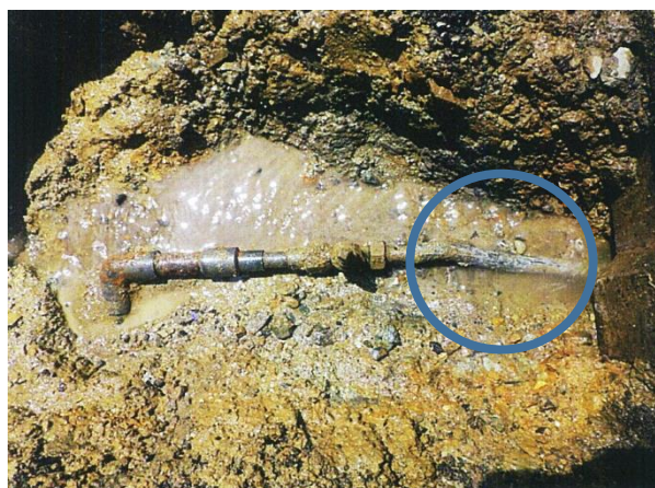
漏水修繕工事にあわせて鉛管撤去
