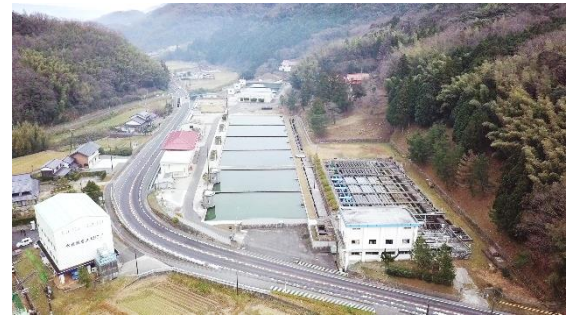
耐震化工事を行う忌部浄水場(写真中央が緩速ろ過池)
