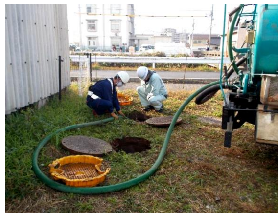
バキューム車による汚水移送作業
