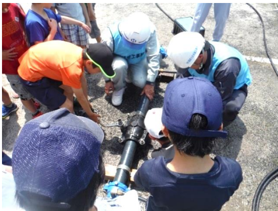
漏水修繕の実演
