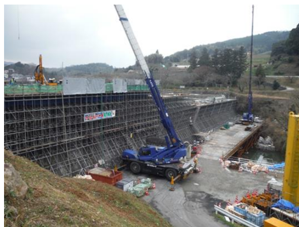
ダム PS アンカー工仮設・アンカー挿入工事
