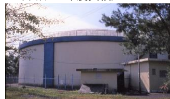
矢田配水池(昭和 45 年 5 月 (1970 年) 築造)
